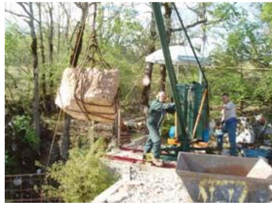
A part creuser encore et encore, l'objectif de début août est la motorisation électrique en triphasé de la grue (en remplacement du vieux diesel) : faut « juste » changer le moteur/poulie et dérouler dans les arbres (voire planter des poteaux) 650m de câble en 25mm<sup>2</sup>.
