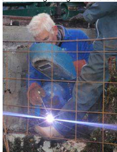
Jean-Bernard Roche à la confection d'une protection périphérique, de l'igüe, en fer à béton
