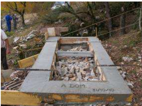
Le massif terminé pour accueillir la grue
