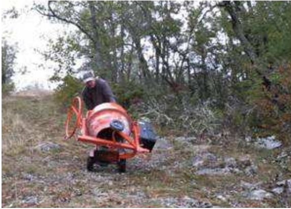
Jean-Louis à la bétonnière 4X4, il nous faut tout apporter, même l'eau du béton
