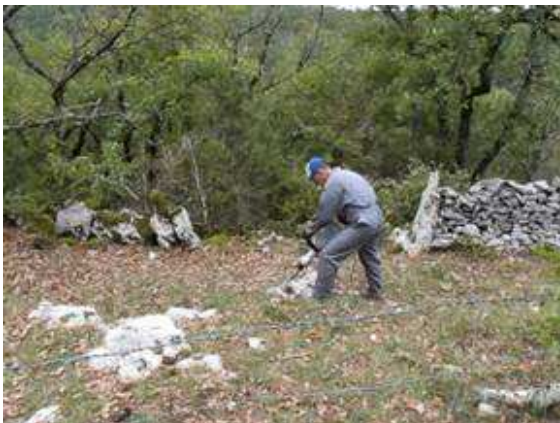
R2D2 au dérochage pour la route d'accès
