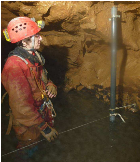
Nadine Duger devant l'installation d'un des puits de tranquillisation (photo Vincent Schneider)
