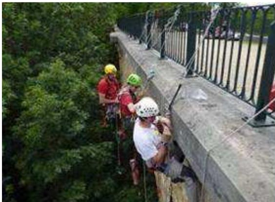
Cette journée nous scellerons 8 broches sur le viaduc 4 (2 relais constitué par 2 broches) de chaque côté du parapet. Nous poserons ensuite, dans la continuité des broches posées, des chevilles autoforeuses (10 ) afin d'installer une main courante à l'aide de plaquettes vissées.
